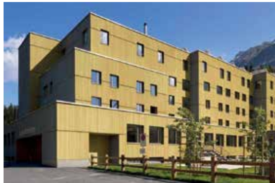
Die vierfarbige Fassadenhaut in Schweizer Fichte ist mit einer Roggenmehllasur behandelt. (Bild: Ralph Feiner)
