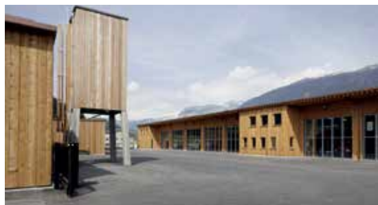
Die beiden Hauptgebäude bilden einen windgeschützten Hof. (Bild: Ralph Feiner)
