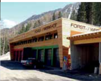
△ Forst- /Werkhof mit Feuerwehrhalle Samnaun Compatsch
