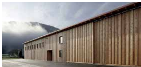
Die Fassade des Hauptgebäudes besteht aus vertikalen Kanthölzern, die ineinandergefügt aufgereiht sind. (Bild: Ralph Feiner)
