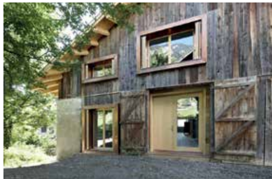
Von aussen ist der Umbau kaum sichtbar, das Dorfbild bleibt somit erhalten. (Bild: Ralph Feiner)
