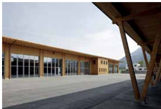
Der neue Werkhof bietet Platz für die Forst- und Werkbetriebe sowie die Feuerwehr. (Bild: Ralph Feiner)
