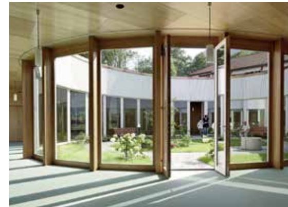
Die verglaste Aussenwand gegen den Hofgarten wird von Eichstützen getragen. (Bild: Ralph Feiner)
