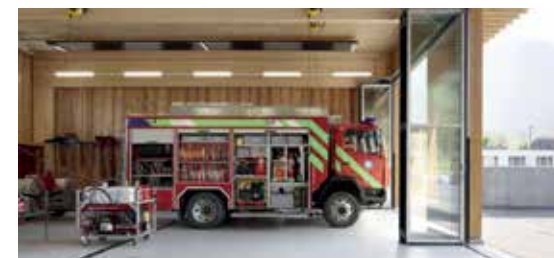
Die dicke Holzschalung übernimmt im Bereich der Fahrzeughallen Wärmedämmung und Winddichtung mittels einer Schicht. (Bild: Ralph Feiner)
