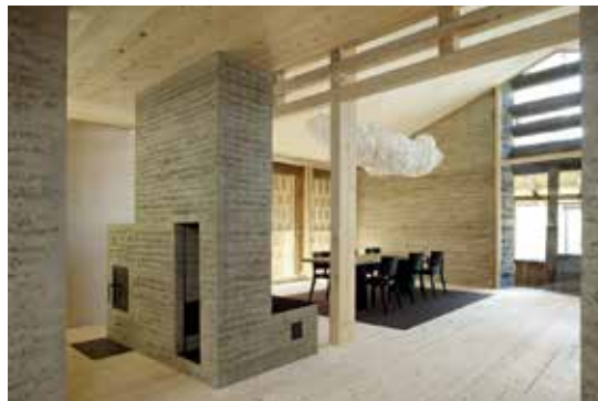
Die Raumbildenden Elemente sind aus Stampflehm erstellt und dienen der Gestaltung, der Haustechnik und sind als tragende Elemente eingesetzt. (Bild: Ralph Feiner)
