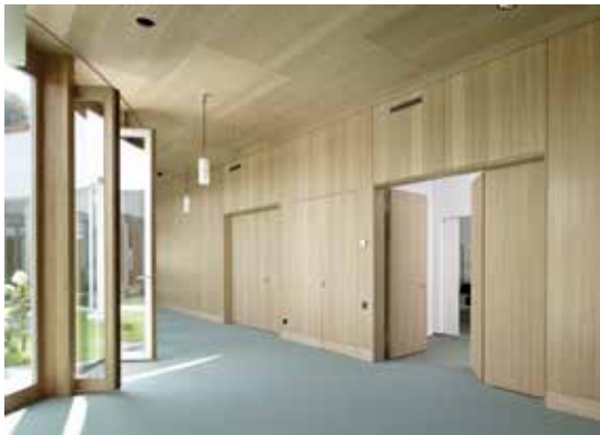
Der grosszügige Gruppenraum ist mit Eichenholz verkleidet. (Bild: Ralph Feiner)
