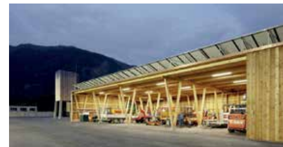
In den Unterständen ist ein Teil des Maschinenparks sowie eine Recyclingsammelstelle eingerichtet. (Bild: Ralph Feiner)
