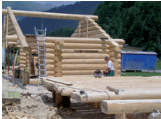
Ein Blockhaus entsteht
