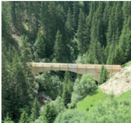
Blick ins Val Mulin mit der neuen Brücke
