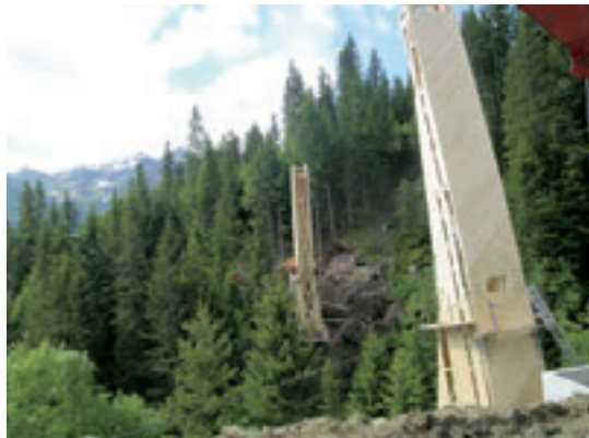
Brücke beim Zusammenbau vor Ort
