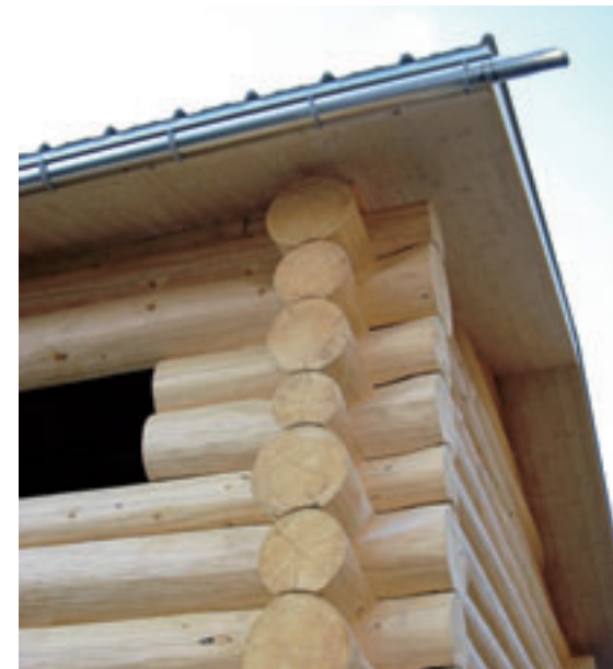
Die Sattelkerbe erfordert sehr genaues Arbeiten
