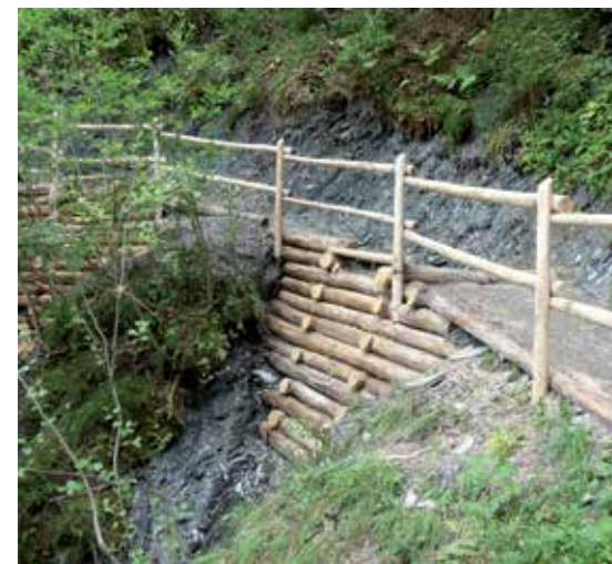
Die Wanderwege müssen auf Grund der besonders erosionsanfälligen Gesteinsschichten laufend ausgebaut und wiederhergestellt werden
