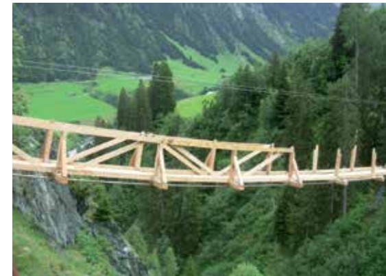
Der Fachwerkbau wurde vor Ort auf zwei vorgespannte Tragseile montiert
