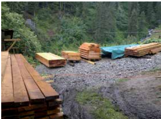
Das Material für die vorwiegend aus Bündner Lärche bestehende Hängebrücke liegt zur Montage bereit
