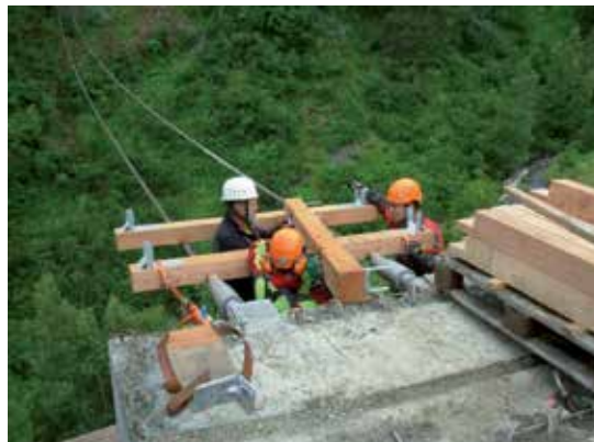
Die Errichtung der Brücke war eine Herausforderung für die Forstwartlehrlinge
