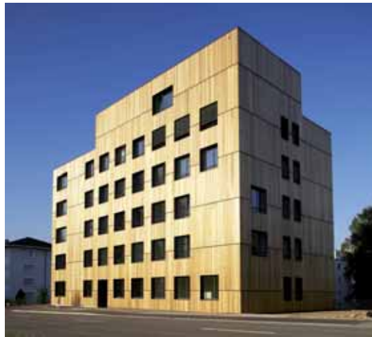
Erstes 6-geschossiges Holzhaus der Schweiz in Steinhausen (Bild Renggli, Sursee LIGNUM)
