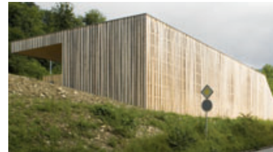
Forstwerkhof Burgergemeinde Biel BE
