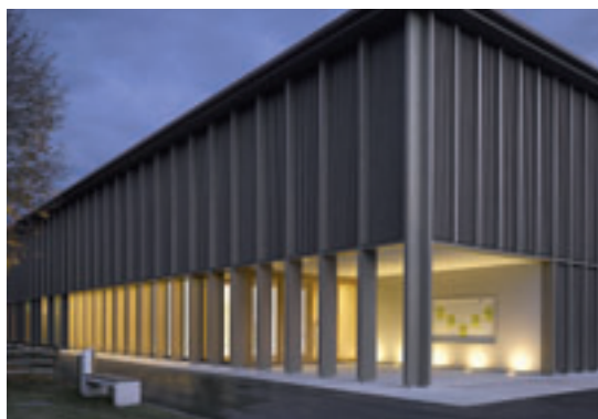
Gemeindesaal und Kirchgemeindehaus, Flawil SG
