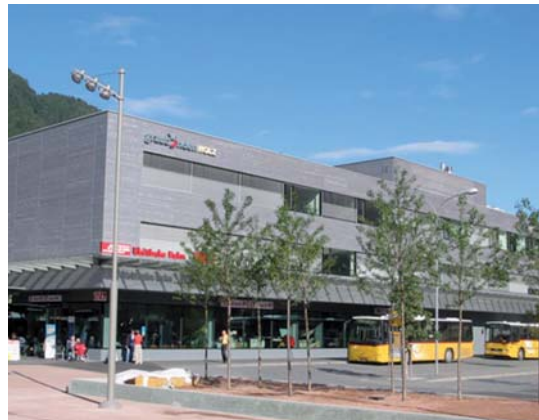
Dank umfassender Planungshilfe werden Holzbauten zum Kinderspiel. Hier am Beispiel Bahnhof Landquart. (Bild Graubünden Holz)
