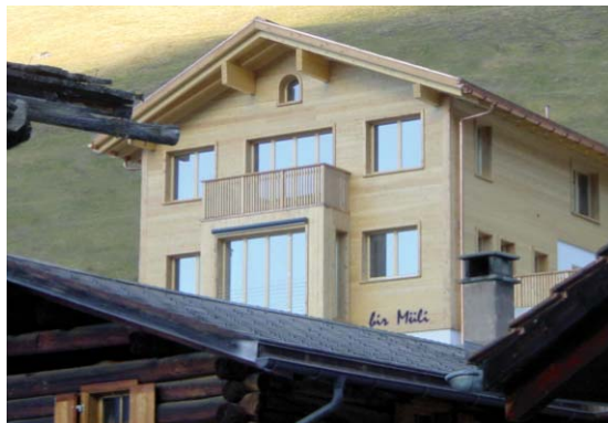
Ökologisch bauen damit, sich der Bauherr in seinen neuen vier Wänden rundum wohl fühlt. (Bild: Holz Bernhard)
