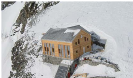
Erfolgsgeheimnis Qualität: Auch im hochalpinen Gelände wie hier beim Bau der Marco e Rosa Hütte gilt diese Devise. (Bild: Holz Bernhard)
