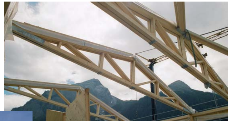
Dachstuhl FW Lokal Bergün
